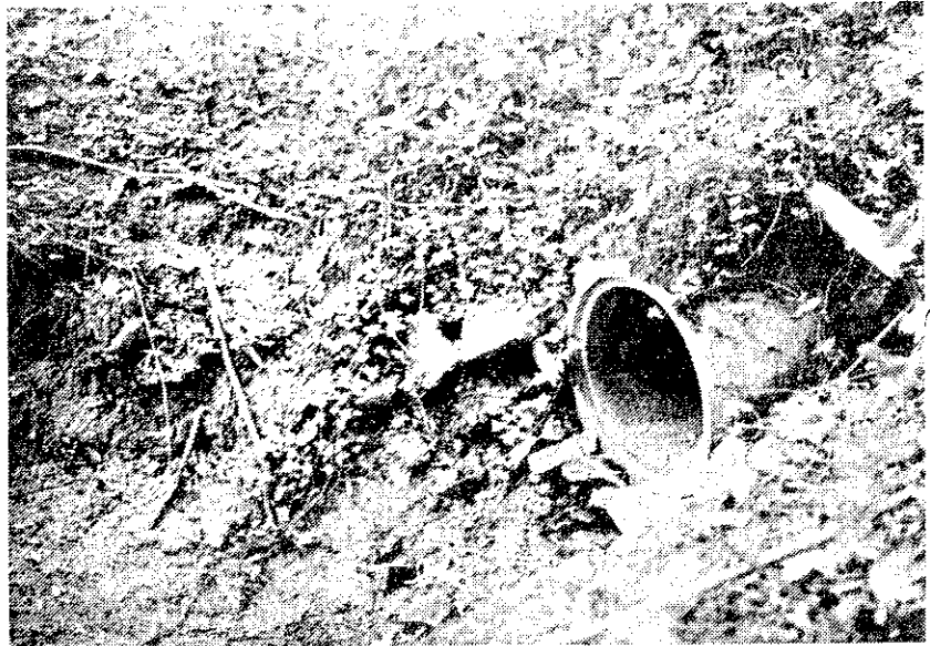
Einleitungen von Autobahnabwässern in den Hühnerbach, wie hier in der Nähe der Horstmannsmühle, sollen durch Ölabscheider entgiftet werden, fordert die AGNU.
