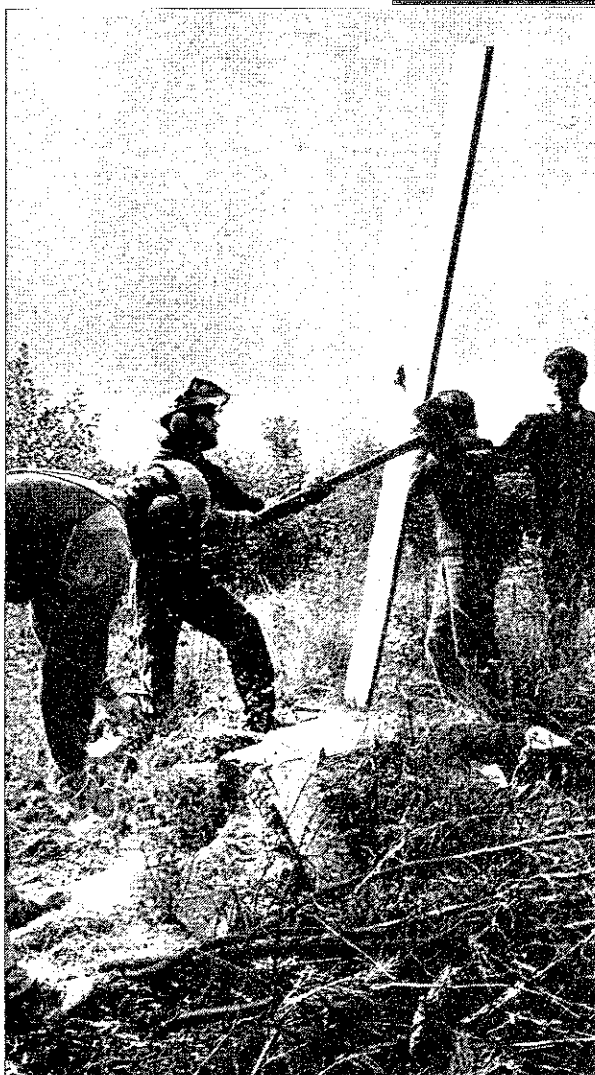
Mit Staufstufen aus Brettern und Pfählen sperrt die „Zivildienstgruppe Umweltschutz“ die alten Entwässerungsgräben, um den ursprünglichen Moorcharakter wiederherzustellen.
